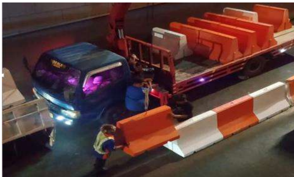
Gambar 16. Pemasangan Concrete Barriere
