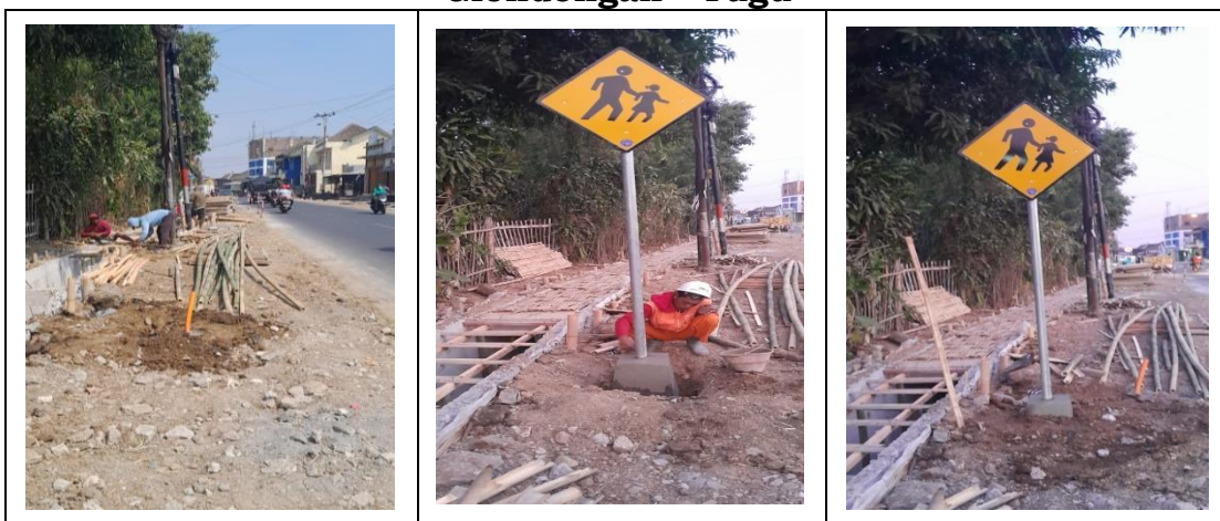
Gambar 28 Rambu Perlengkapan Jalan di Ruas Jalan Mulur - Sidan
