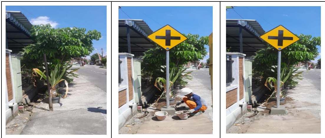
Gambar 23 Rambu Perlengkapan Jalan di Ruas Jalan Gunung Slamet
