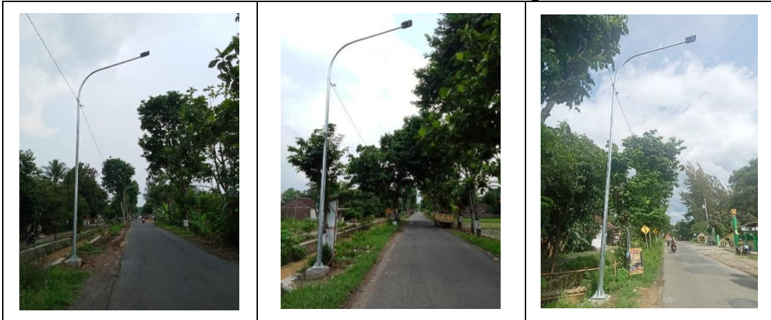
Gambar 11 Tiang Penerangan Jalan Umum 9Meter di Ruas Jalan Mulur - Bancaan
