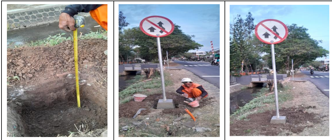
Gambar 33 Rambu Perlengkapan Jalan di Ruas Jalan Bendosari
